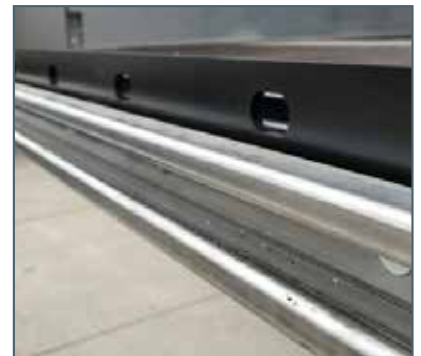
Dolní vodicí kolejnice Masivní kolejnice z nerezů přišroubovaná k vnějšímu rámu
