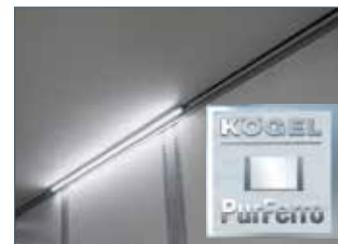
Painéis sanduíche PurFerro: Revestimento de cobertura em aço com núcleo de espuma PUR
